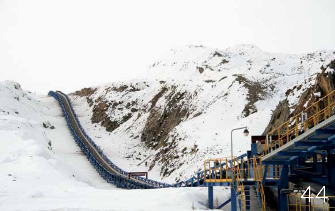
Inspection des rouleaux de convoyeurs
