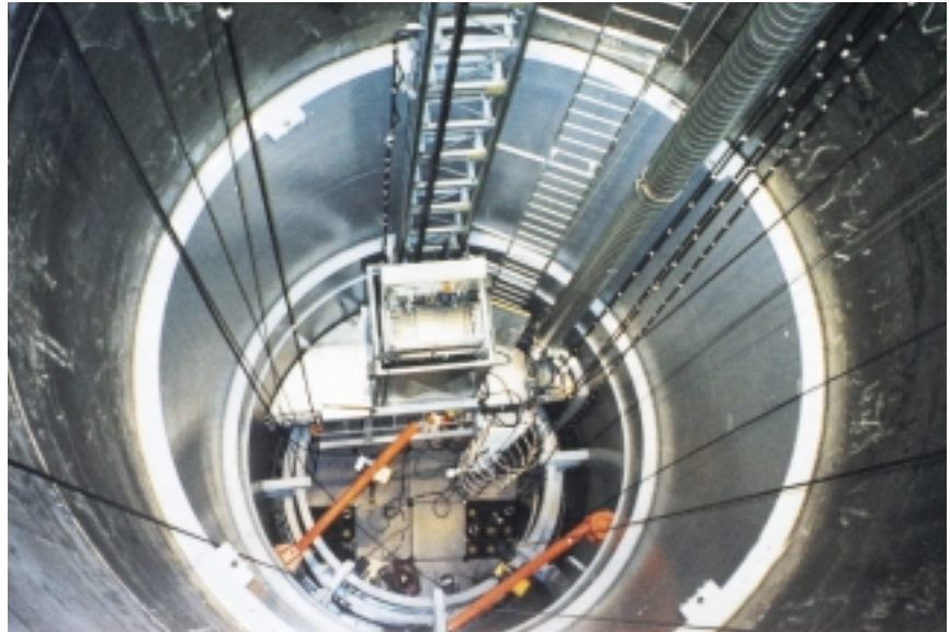
Stahlzylinder mit Strahlenabschirmung und Personenaufzug im Reaktordruckbehälter
