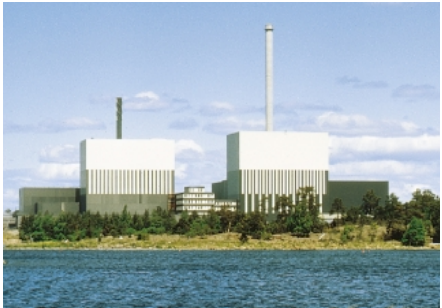
Kernkraftwerk Oskarshamn an der Ostsee. Links Block 1, das erste kommerzielle Kernkraftwerk Schwedens. Der zugehörige Reaktor von ABB Atom wurde Anfang 1972 in Betrieb genommen und hat heute eine elektrische Nettoleistung von 440 MW. 1
