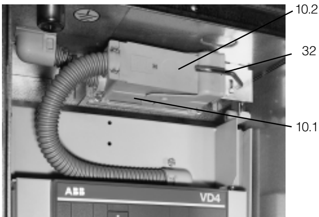
Figura 3/16: Bloqueo mecánico del enchufe
