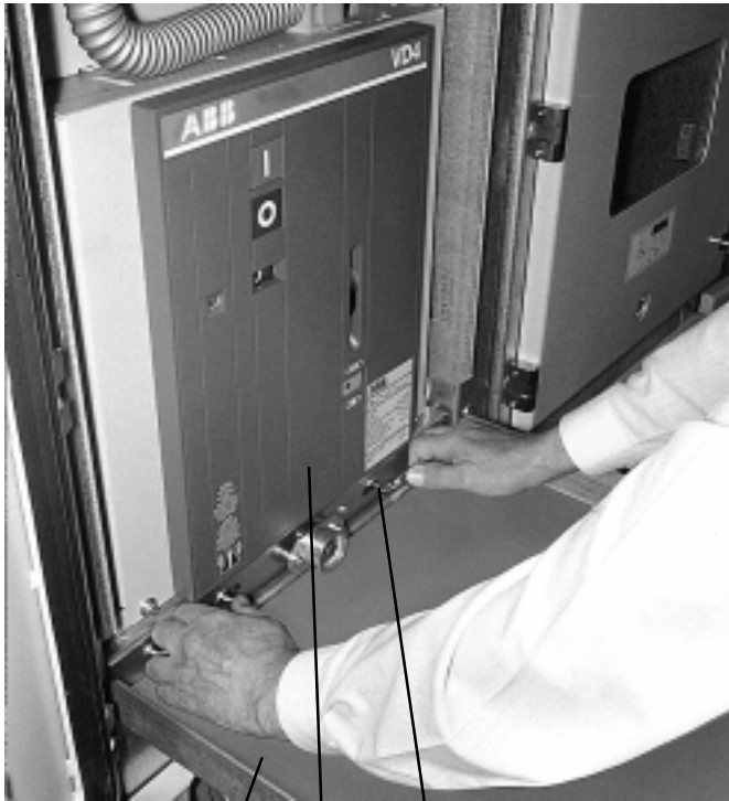
Figura 6/9: Carro de servicio enclavado en el panel. Desbloquear la unidad con las manijas para sacarla
