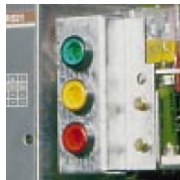
Señalizador del estado de la presión del gas SF6 (bajo demanda)
