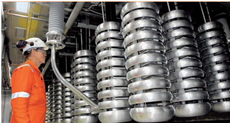
3 IGBT 阀：换流器的核心
