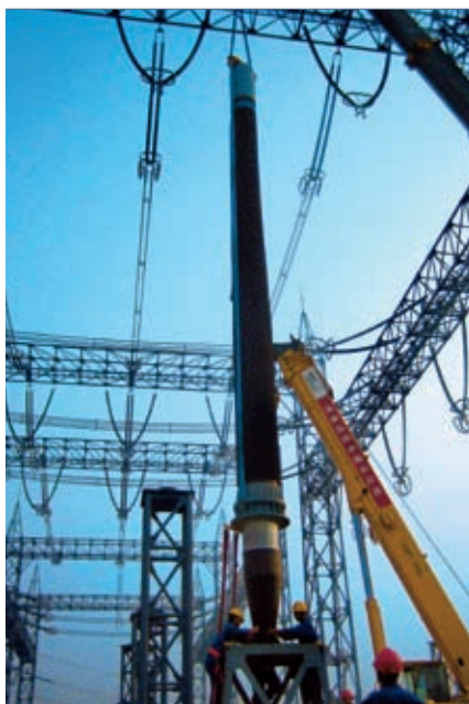
3 1,100 kV交流套管的安装（2008年）
