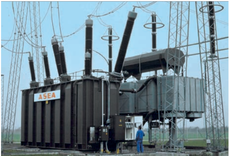
装有卢德维卡套管的 Konti Skan II 变压器。Konti Skan 是丹麦与瑞典之间的高压直流输电线路。
