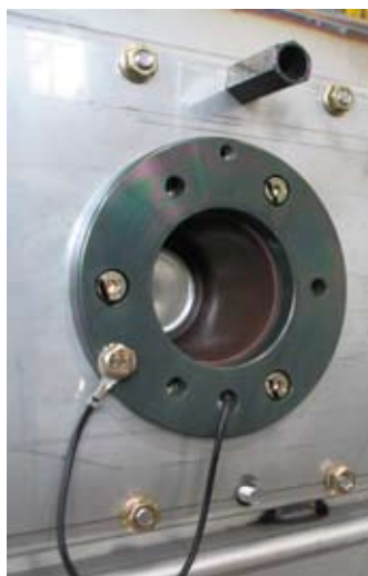
用于开关柜侧扩展的外部母线连接的内锥（接口2）套管并
