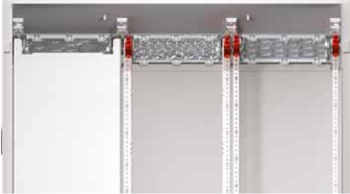
Installatie met montageplaat, WR- en EDF-montageframe
