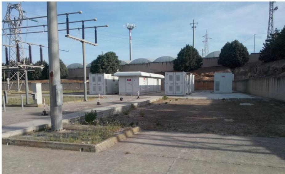
100 da 1 MW ciascuno, oltre che alla cella trasformatore elevatore (477/20000 V-2,65 MVA), al sistema di controllo, comando e misura e al quadro MT 20 kV. Nel quarto container è alloggiato il filtro attivo tipo PQFI 450A.
