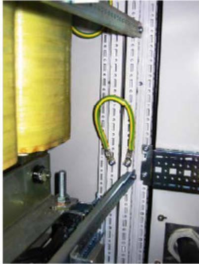
图 24：单元接地连接图
