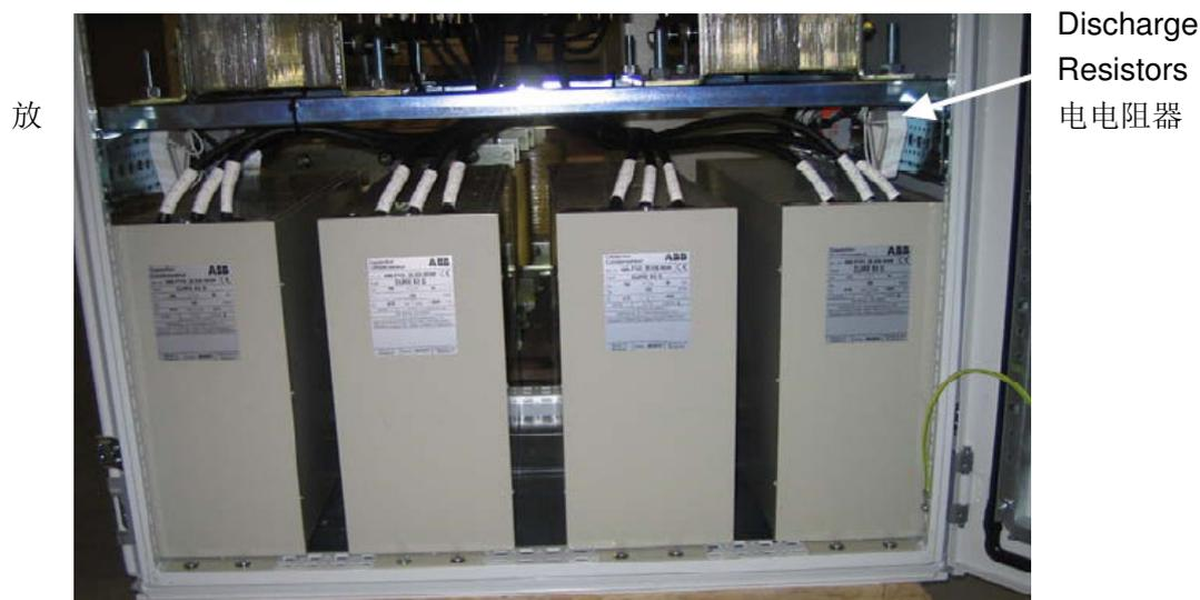
Figure 10: CLMD83Q capacitors 图 10: CLMD83Q 电容器
