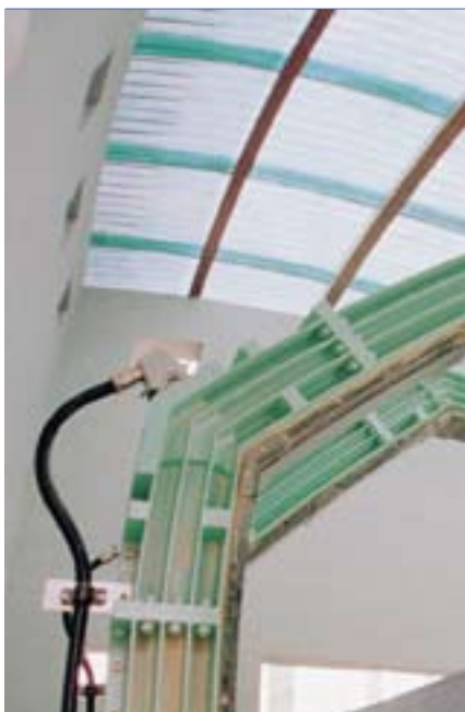
Два традиционных преобразователя постоянного тока на эффекте Холла на 400 кА
