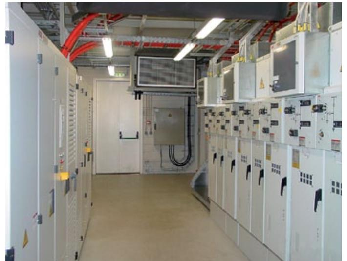
Sala de control con convertidores de velocidad variable ACS 2000 (izquierda) y cuadros eléctricos UniMix (derecha).
