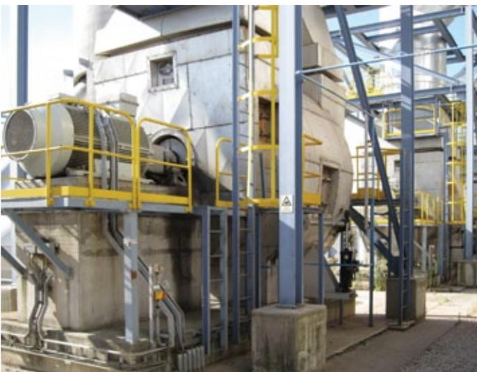
Los tres ventiladores de tiro inducido en la planta de valorización energética de residuos de Valorsul se controlan a través de convertidores de velocidad variable ACS 2000 de ABB.
