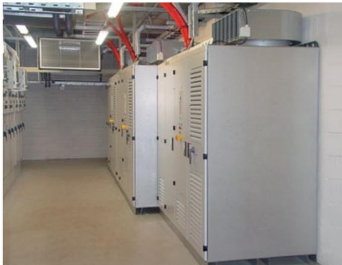
Tres convertidores de velocidad variable directos a línea ACS 2000, con potencia de 700 kW, controlan los ventiladores de tiro inducido en la planta de valorización energética de residuos de Valorsul.
