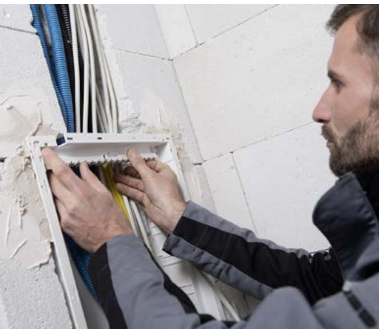
01 Le grand espace de raccordement facilite grandement les travaux d'installation.
