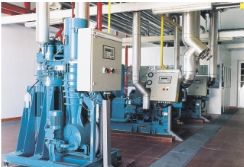
Compresseur à vis d'une installation frigorifique espagnole pour denrées alimentaires. Le groupe d'entraînement STAL Rotatune avec le compresseur à vis FV 19 et l'économiseur fournissent la régulation de la puissance de l'installation. 10
