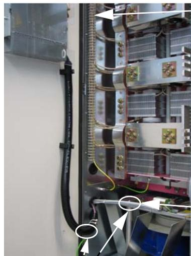
Les conduites de câbles internes sont utilisées pour les câbles d'amortissement. Ne les utilisez pas pour d'autres câbles, par exemple les signaux de processus !
