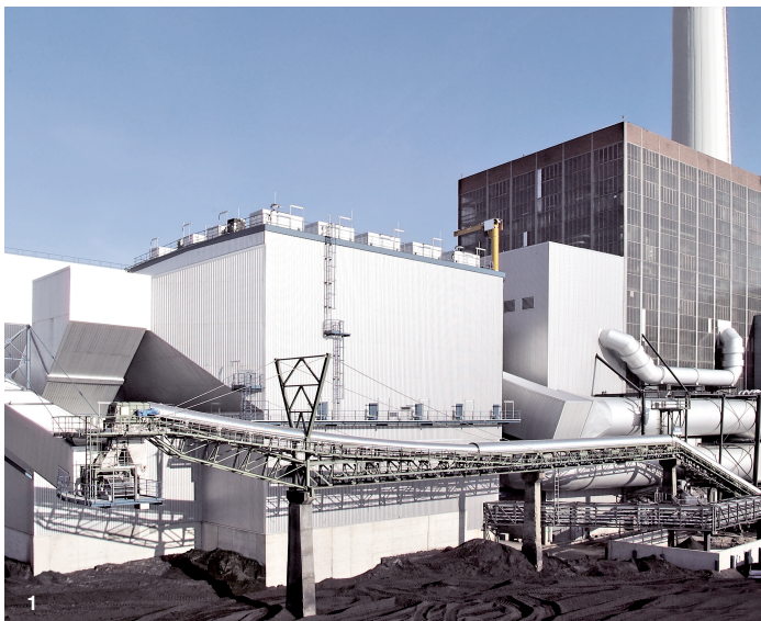
1 Grosskraftwerk Mannheim (GKM), Germany | 2 Mälarenergi Västerås, Sweden
