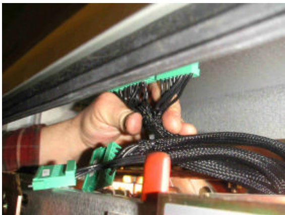
6.15 Connect the terminal XF60, XF61, XF62 och XF63.
