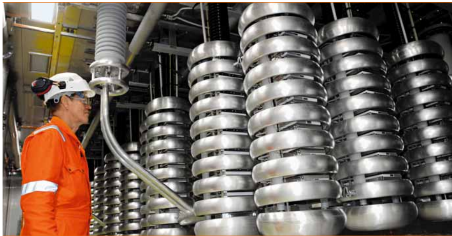
3 Les valves IGBT, au cœur du convertisseur
