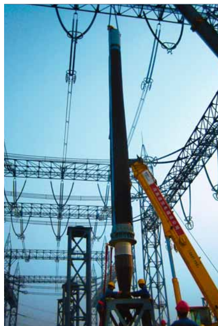
3 Installation d'une traversée 1100 kV CA (2008)
