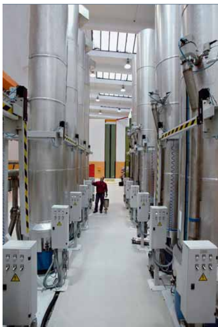
2 Imprégnation des traversées à résine
