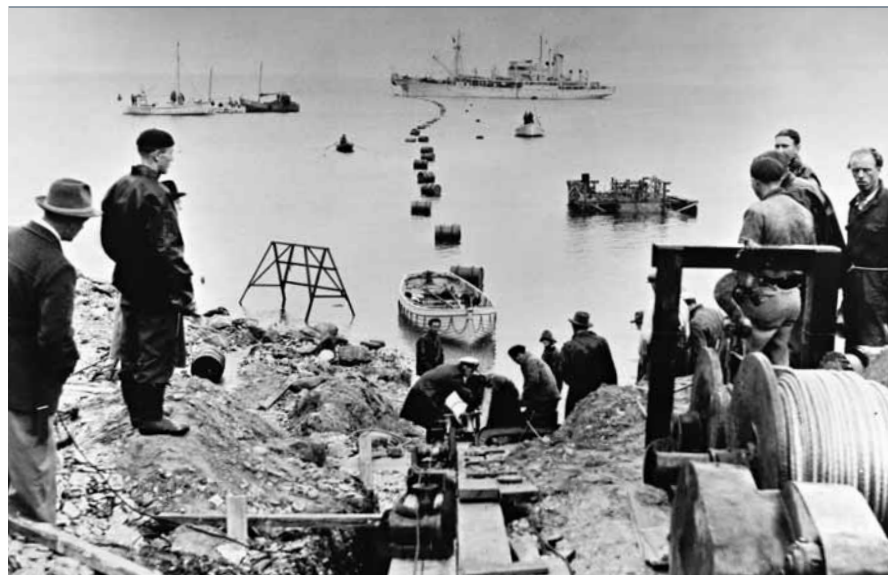
Tendido del cable para el enlace HVDC de Gotland en 1954
