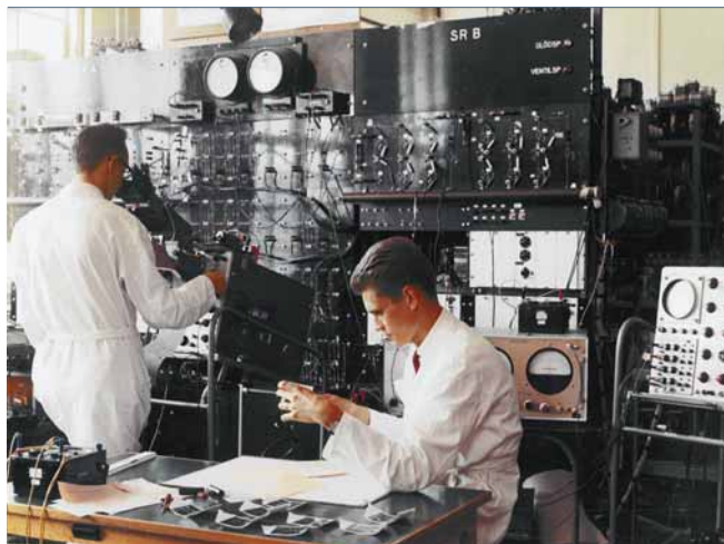
Simulador analógico utilizado en el diseño de los primeros sistemas de transmisión HVDC
