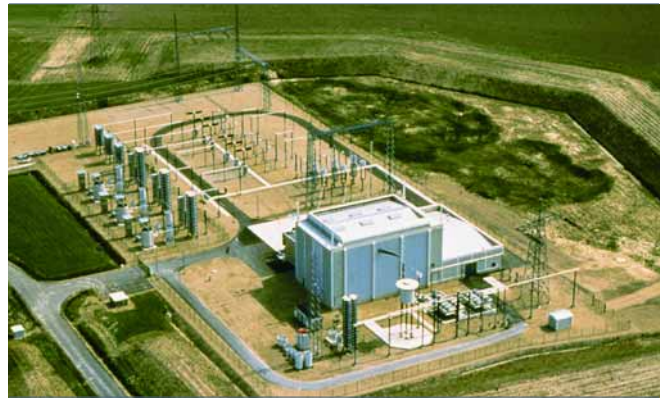
Estación convertidora Baltic Cable HVDC
