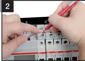
Platzierung der Steckverbinder mit Stift markieren
