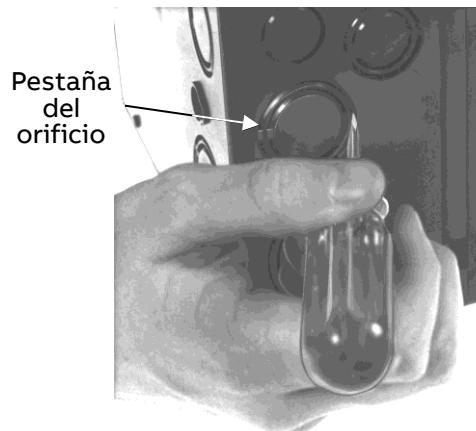
Figura 2. Posición del destornillador para un orificio externo concéntrico.
