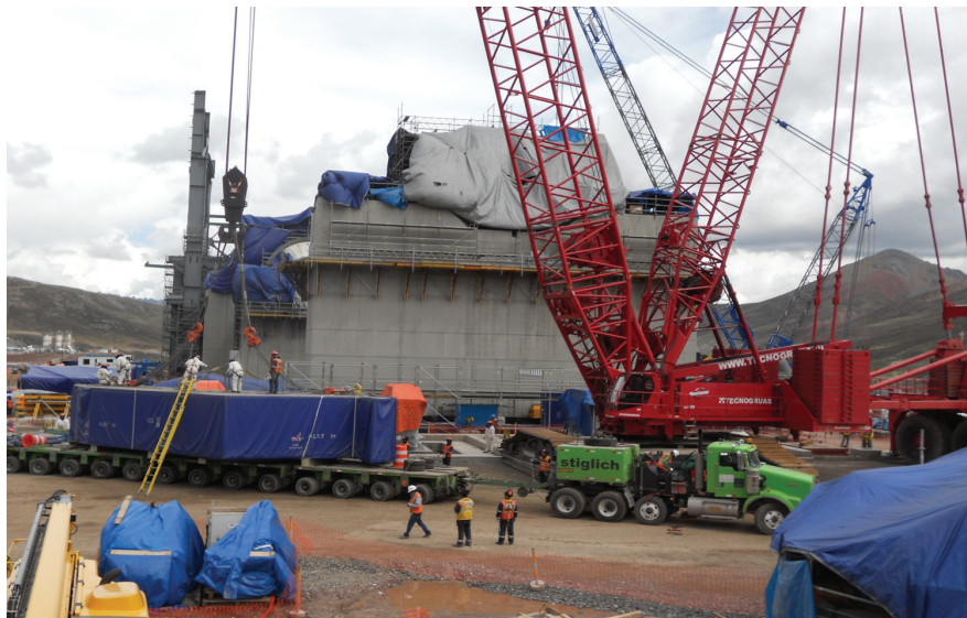
Montaje de piezas del molino sin engranajes
