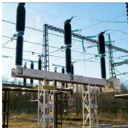
8 Disjoncteur à cuve sous tension pour un pouvoir de coupure de 40 kA sous 170 kV maxi
