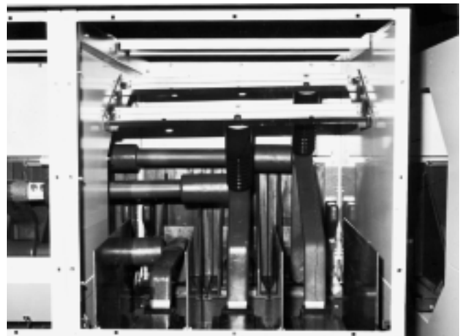
Cellule de remontée barres avec mesures Bus riser cubicle with measurements
