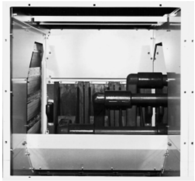
Cellule finale, avec fermeture du passage des câbles des barres omnibus End cubicle with omnibus busbar cable passage closure
