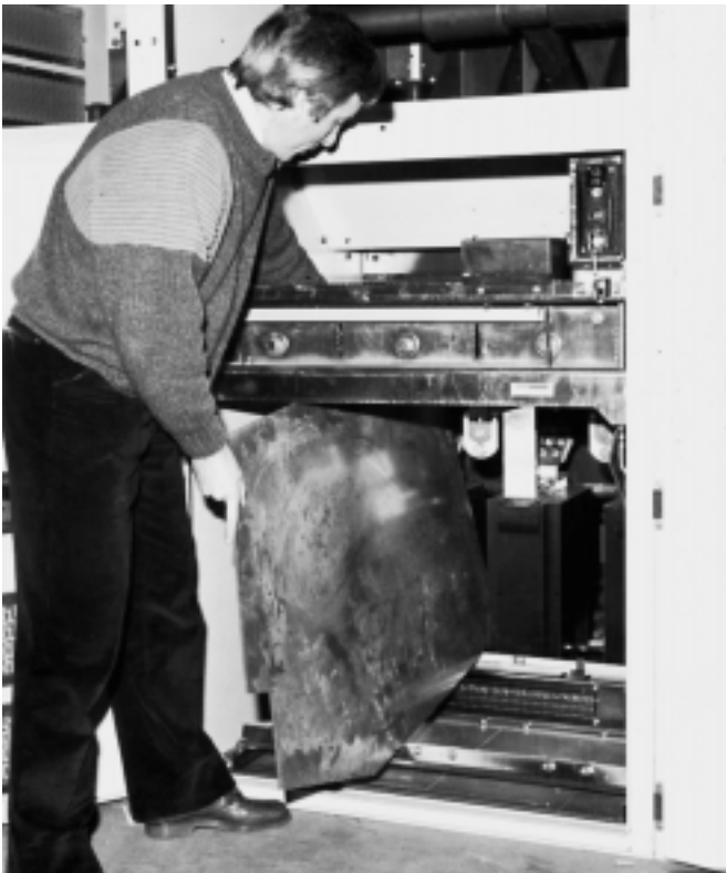
Assemblage des cloisons dans le compartiment de ligne Assembly of partitions in the feeder compartment
