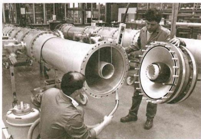
Výroba zařízení pro rozvodné sítě v roce 1988.
