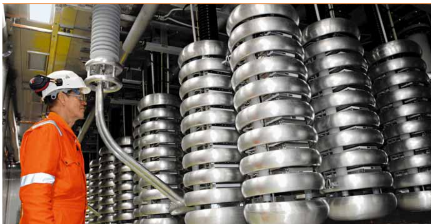
3 Les valves IGBT, au cœur du convertisseur
