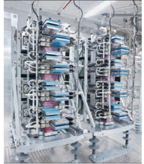
Fingrid, el operador del sistema de transporte finlandés, acudió a ABB para instalar dos condensadores en serie (de 301 y 369 MVar) para atender la demanda de transporte interno, mejorar la estabilidad de la red y potenciar el corredor de exportación a Suecia en 200 MW → 1.
