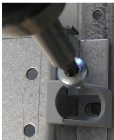
Rys. 22 / Fig. 22 Mocowanie uchwytu ze śrubą Fixing of the cage
