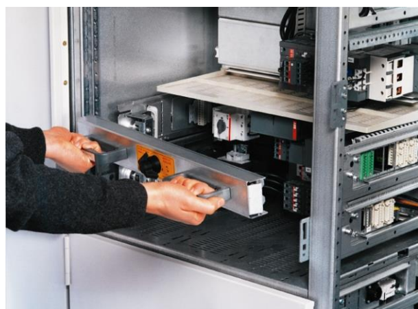
Rys. 79 / Fig. 79 Zakładanie uchwyty serwisowego Inserting the service handle
