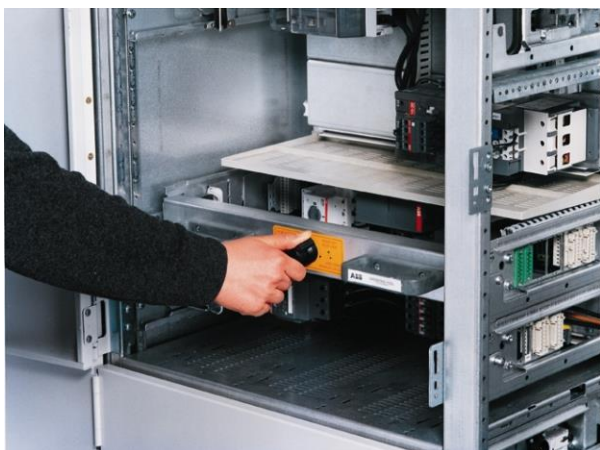
Rys. 57 / Fig. 57 Zablokowanie uchwytu serwisowego Locking the service handle when simultaneous unlocking the module
