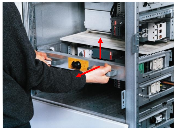
Rys. 58 / Fig. 58 Podnieś uchwyt serwisowy nieznacznie do góry i wyciągnij moduł do pierwszej pozycji wysunięcia. Odłącz uchwyt serwisowy i zablokuj moduł. Usun uchwyt serwisowy Lift module slightly and pull it out up to the first engaged posi- tion. Unlock service handle and lock the module at the same time. Remove service handle.
