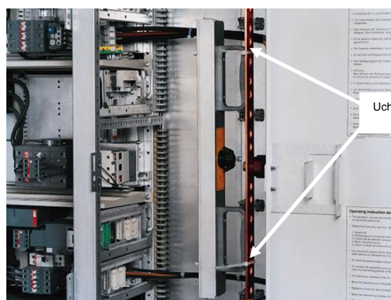
Rys. 23 / Fig. 23 Uchwyt manewrowy zabezpieczony na czas transportu Transport protection of the service handle
