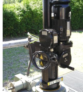
Abbildung 30: Conrac RSDE20 an einer Gasverteilstation
