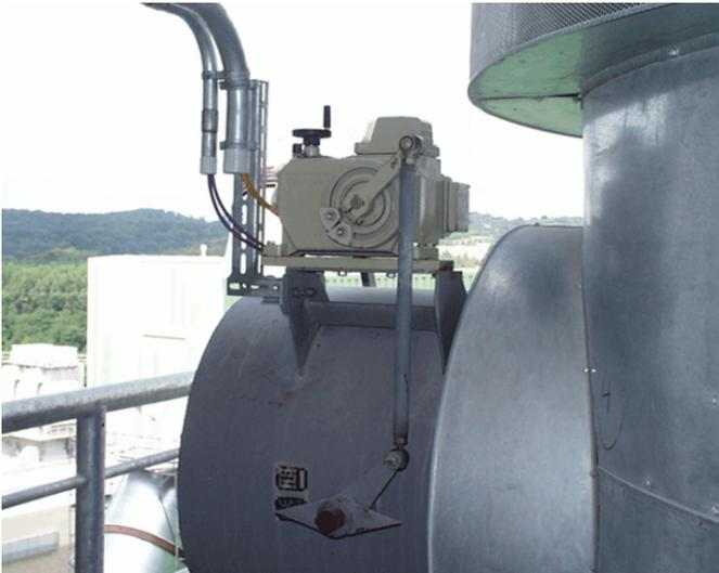
Abbildung 37: Mühlenluftregelung; Schwenkantrieb RHD250 (Nenndrehmoment 250 NM)
