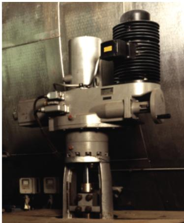
Abbildung 34: Linearantrieb (Speisewasservorwärmung)
