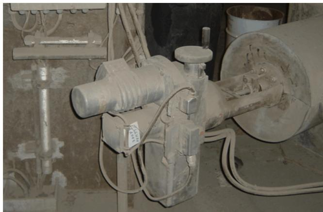
Abbildung 12: Horizontal montierter Linearantrieb
