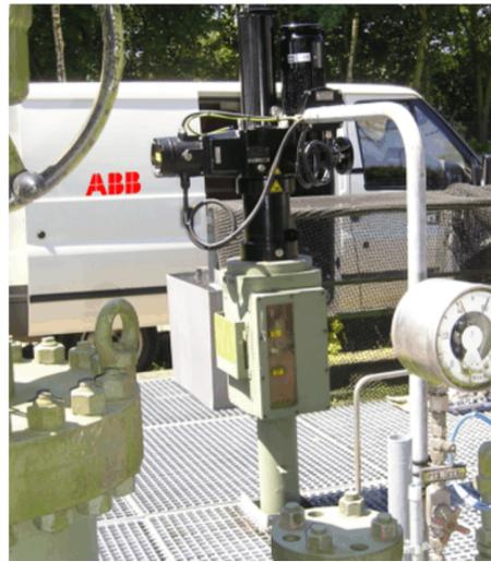
Inbetriebnahmeunterstützung bei Installation eines explosionsgeschützten Linearantriebs RSDE10 durch ABB-Fachpersonal
