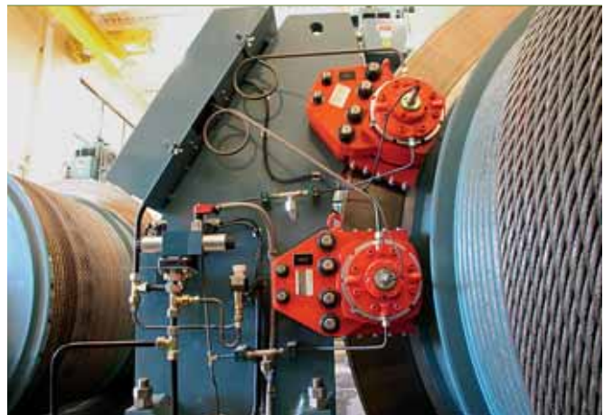
6 Bremssteuerventile an den Winden – bewährte ABB-Technik aus dem Bergbau eignet sich auch zum Transport von Schiffen.
