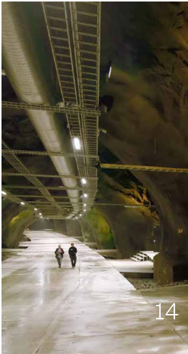
数据中心自动化
