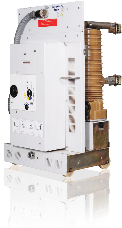
GEC Alstom FP breaker
