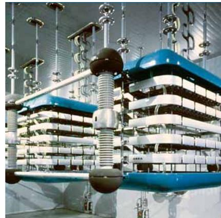
exemple) qui transforment cette électricité en courant continu pour la transporter sur des milliers de km en minimisant les pertes en ligne. A l'autre extrémité, une seconde station reconvertit le courant en alternatif et le synchronise avec le réseau de distribution.
