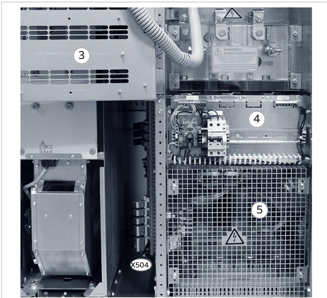
6. Faites cheminer les câbles jusqu'à l'unité de commande (a) et jusqu'au bornier supplémentaire X504 (option +L504), comme illustré ci-dessous.
