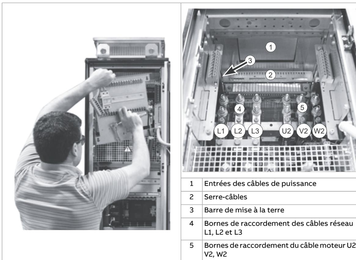
Le schéma suivant illustre l'agencement des bornes de raccordement des câbles de puissance des tailles R6i+R6i et R7i+R7i.
