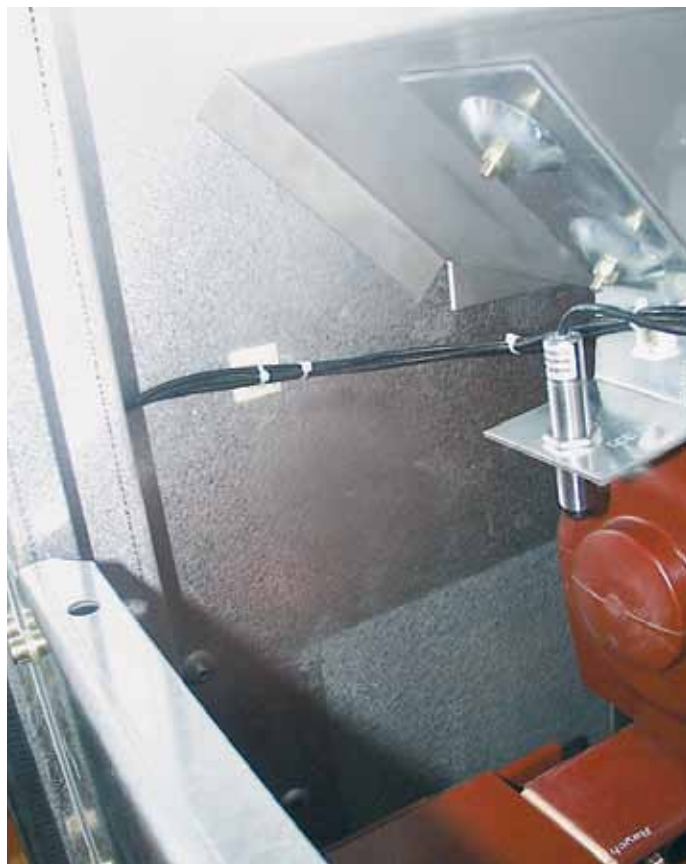
Figura 70: Ejemplo de inspección termográfica en el cuadro UniGear ZS1 de un piso
