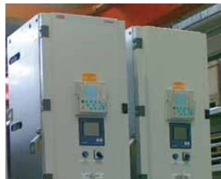
Figura 60: Ejemplo de cuadro UniGear ZS1 con compartimiento de baja tensión altura 1100 mm
