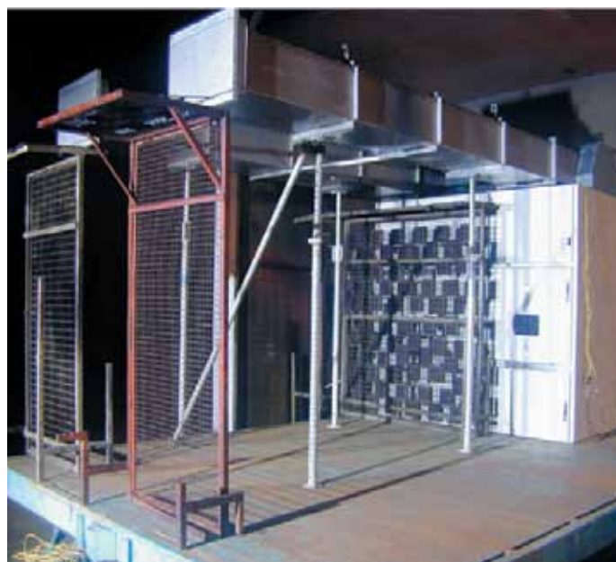
Figura 2: UniGear ZS1 durante la prueba de resistencia al arco interno
