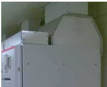
Figura 59: Ejemplo de cuadro con tubo de alivio gases (la altura total del cuadro es 2675 mm para 12-17,5 kV hasta 40 kA)
