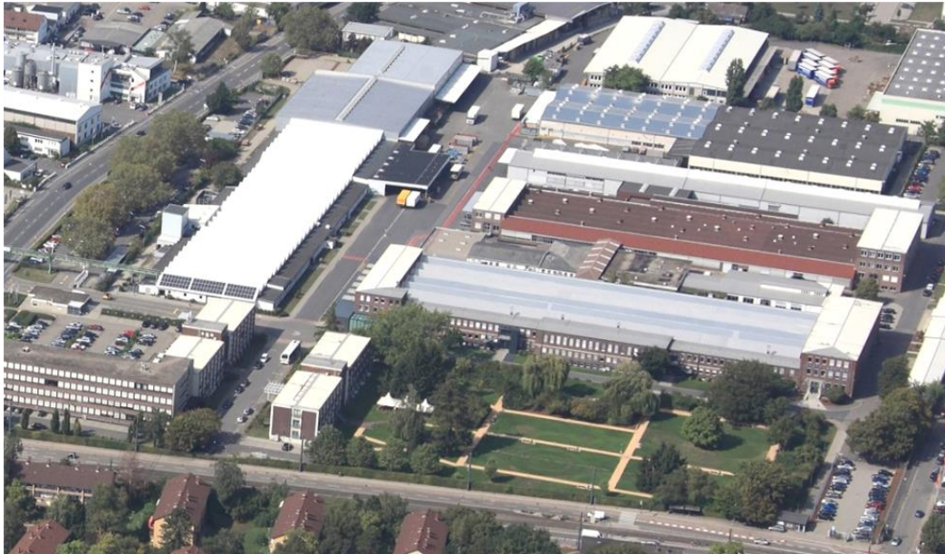
ABB STOTZ-KONTAKT GmbH Heidelberg / Germany
