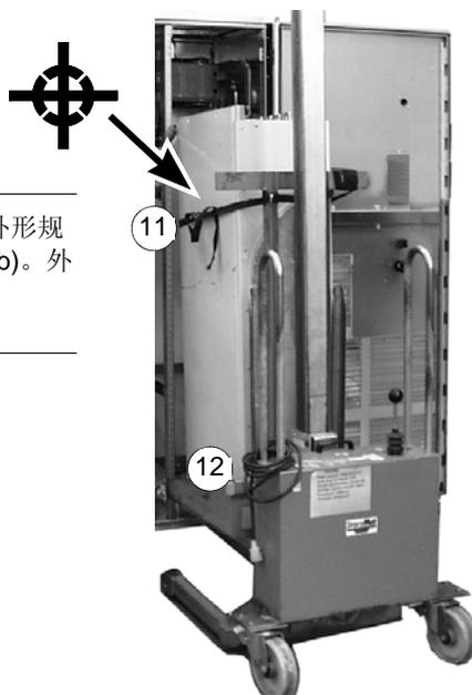
13. 以相反的步骤将新模块装回柜体。
