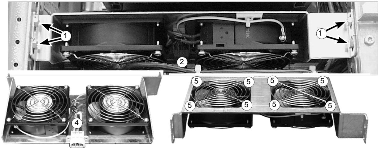
附加柜体冷却风机的更换 ( 仅用于当底部进出线时 IP22 和 IP42 的外形规格为 R7 和 R8 的柜体 )
