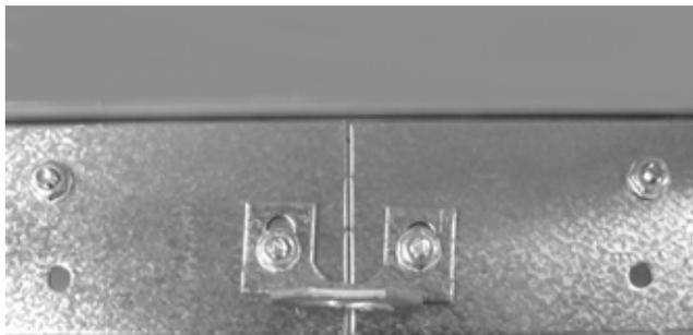
9. Servez-vous du schéma ci-après comme référence pour percer les orifices dans la conduite. Serrez le module sur les bords à l'aide des vis.
