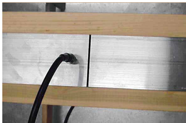
2 Assemblage de deux sections de guide d'ondes par bride étroite assurant l'isolation galvanique sans dégrader la transmission.
