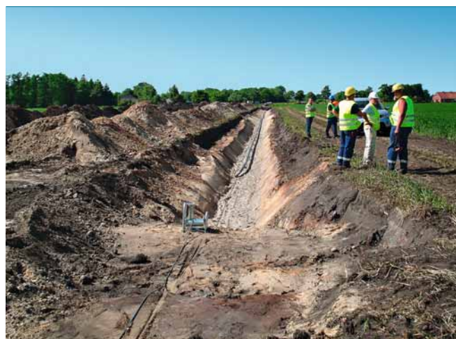
4 Pose des premiers tronçons de câble 400 MW/150 kV dans la région d'Aurich (Basse-Saxe), en juin 2008
