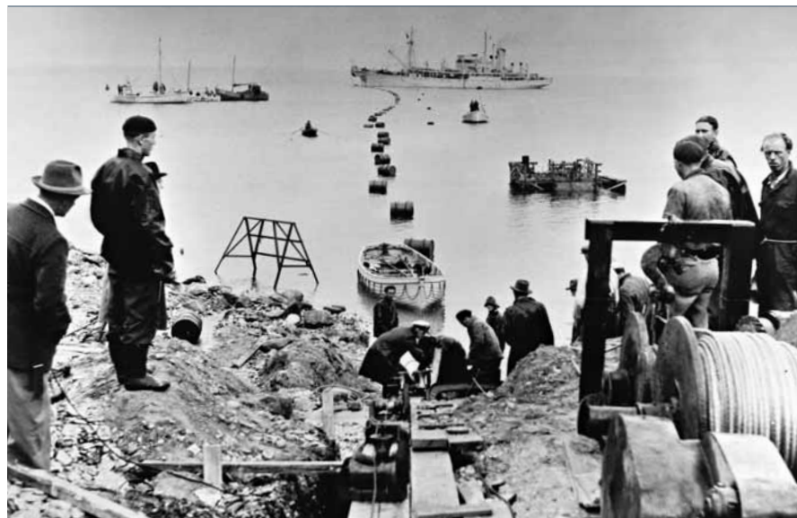
Pose du câble de la liaison CCHT de Gotland en 1954
