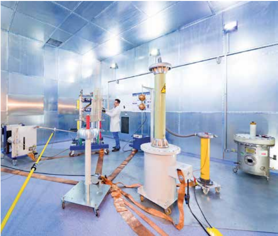
Nowoczesne Laboratorium Nowych Technologii w Elektroenergetyce przeznaczone jest do prowadzenia badań w obszarach wytwarzania, przesyłu, rozdziału i użytkowania energii elektrycznej. (Fot. Filip Grecki)
