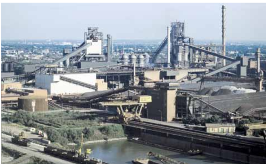
Die beiden Hochöfen im Werkbereich Schwelgern von ThyssenKrupp Steel Europe gehören zu den leistungsfähigsten der Welt.
