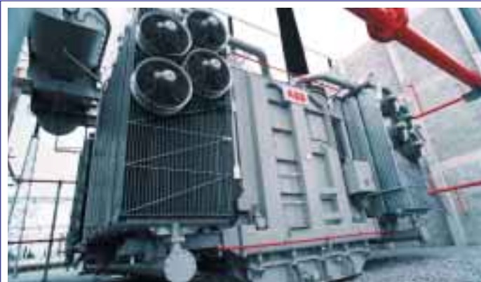
ABB:s system TEC (Transformer Electronic Control) övervakar och skyddar bland annat stora transformatorer, och bidrar därmed till en effektiv och jämn nät drift.
