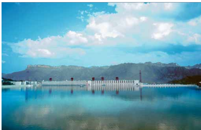
4 Centrale hydroélectrique des Trois Gorges (Chine)
