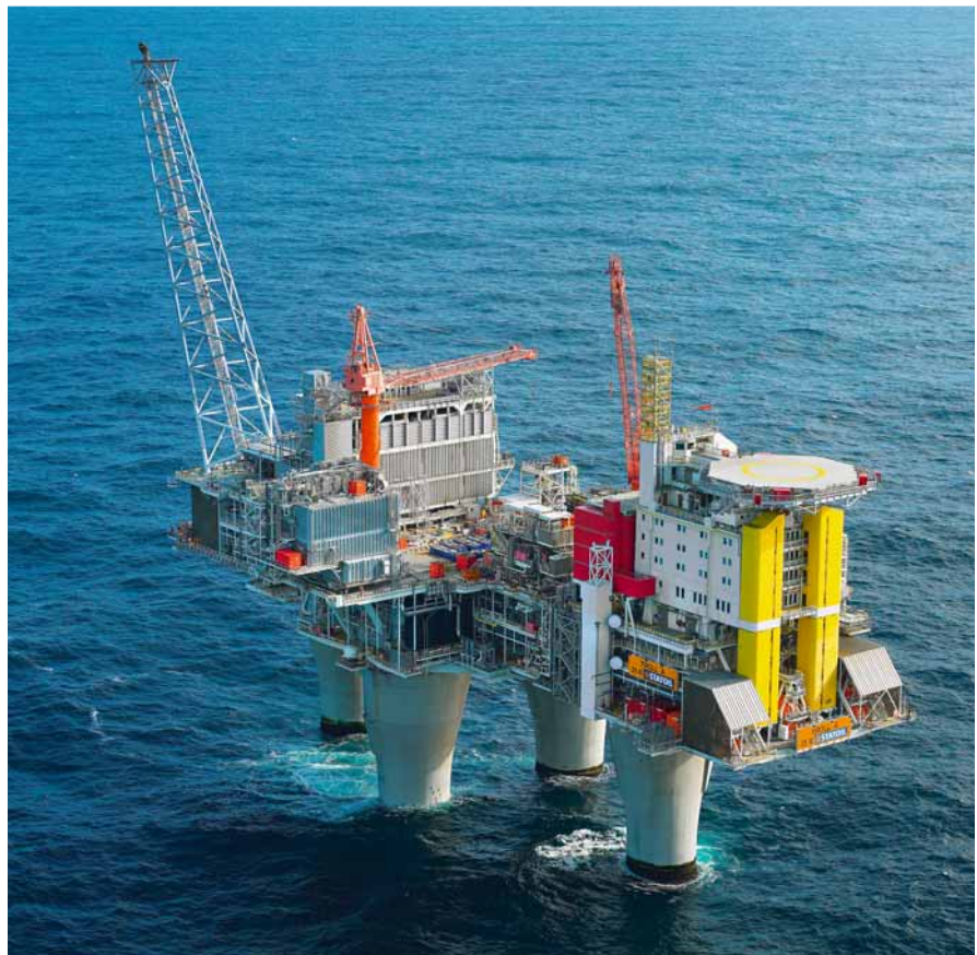
4 Plate-forme offshore gazière Troll A de StatoilHydro en mer du Nord
