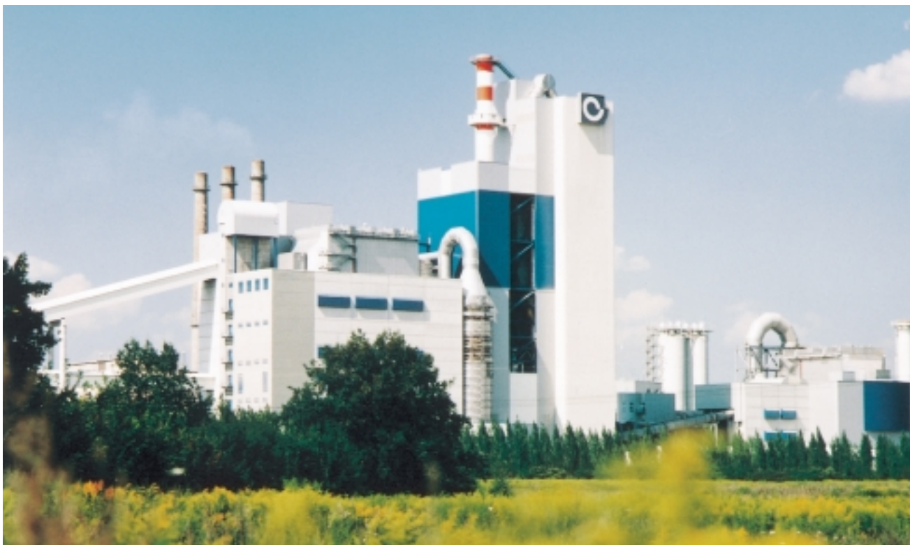
Usine de la fabrique de ciment Rüdersdorfer Zement GmbH. Elle fut entièrement modernisée entre 1991 et 1996. Aujourd'hui, cette usine compte parmi les fabriques de ciment les plus modernes de l'Europe.
