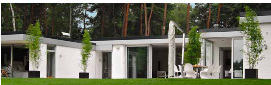
3 Un bungalow modernisé, à Ratingen (Allemagne)
