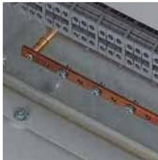
Die Neutralleiter- oder Erdungsschienen, die aus Elektrolytkupfer mit M6 Gewindebohrungen im 25 mm Raster bestehen, sind mittels der entsprechenden Träger an den Rückplatten zu befestigen.
