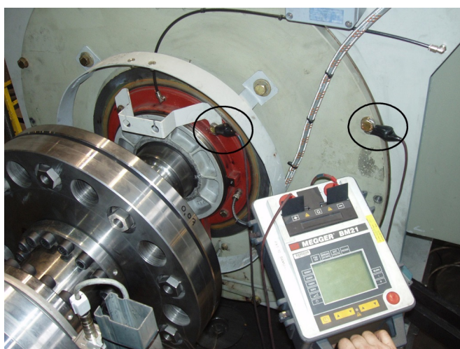
Obr. 28 Meranie izolačného odporu valivého ložiska
