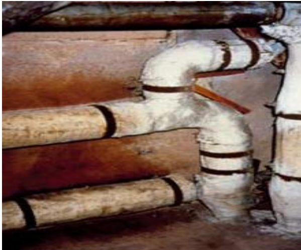
Fotografía 7: Aislamiento de tuberías dañado Fotografía 8: Aislamiento de tuberías dañado
