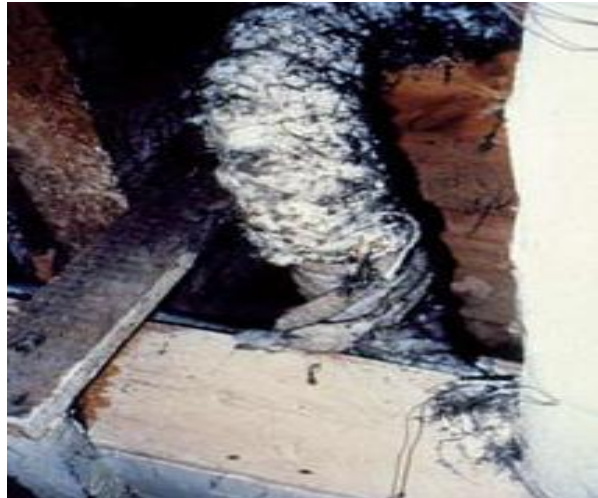
Fotografía 7: Aislamiento de tuberías dañado Fotografía 8: Aislamiento de tuberías dañado
