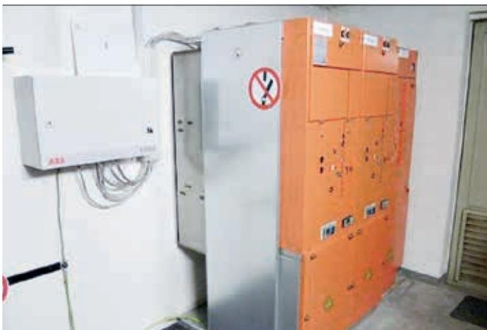
4c Remplacement de l'appareillage existant dans un poste à couloir de manœuvre
