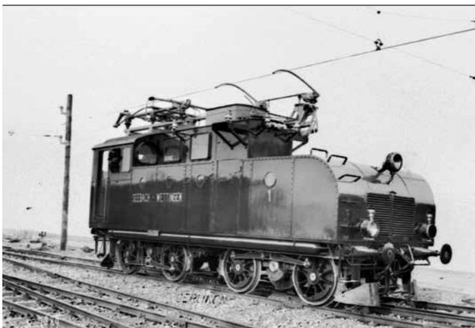
4 Seconde locomotive d'essai Oerlikon à moteurs monophasés (1905)
