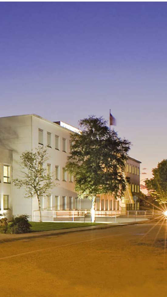
A fianco, la sede di Danieli Automation a Buttrio (Udine), sotto gli interni della sede in allestimento
